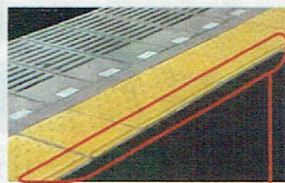
内方線付き点字ブロック
